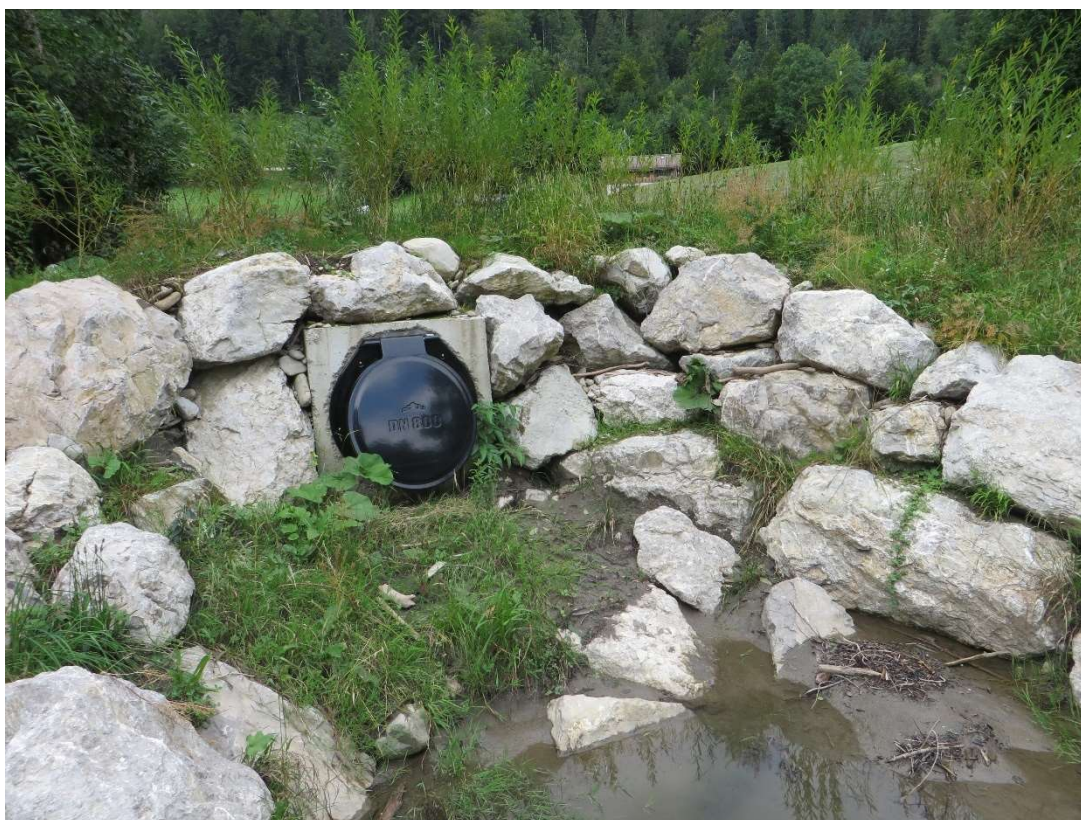
Figure 11 : Exutoire existant, eaux issues du bassin de protection contre les laves torrentielles à l'amont de la gare de La Tine
