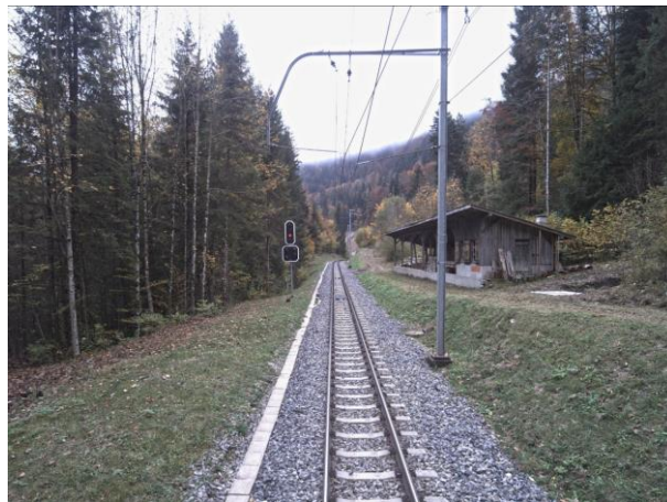
Figure 2 : KM 24.615 – Pleine voie
