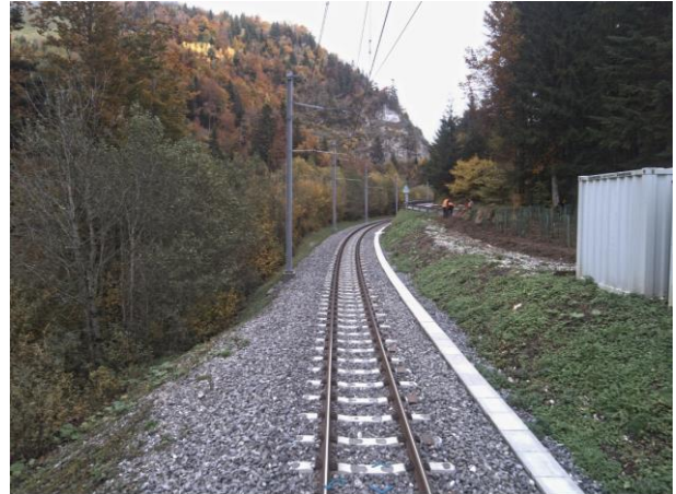
Figure 35 : KM 26.330 – Pleine voie
