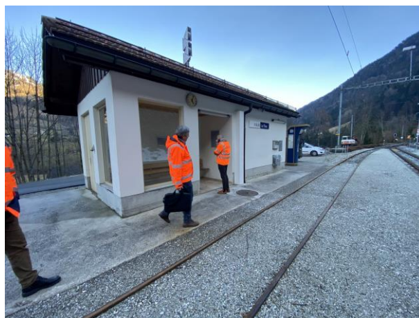
Figure 16 : KM 24.980 – Bâtiment de la gare, façade Sud-Ouest
