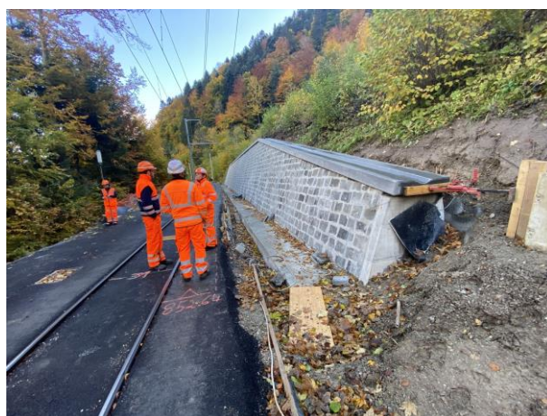
Figure 24 : KM 25.220 - Mur amont secteur des Pâles en construction
