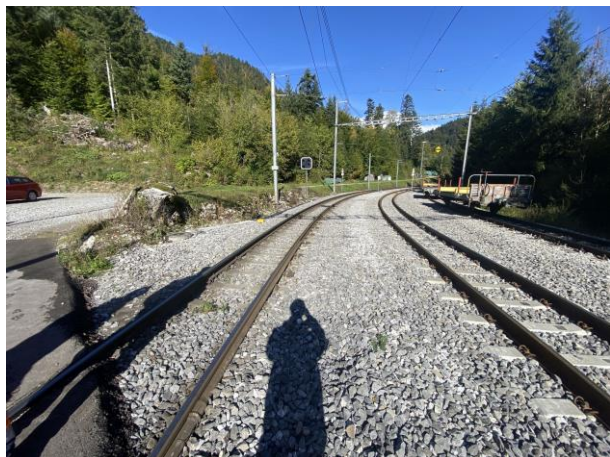
Figure 7 : KM 24.900 – Secteur de gare direction Montbovon
