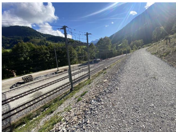
Figure 19 : KM 25.000 – Gare de la Tine, vue amont depuis la route du Revers, direction Rossinière
