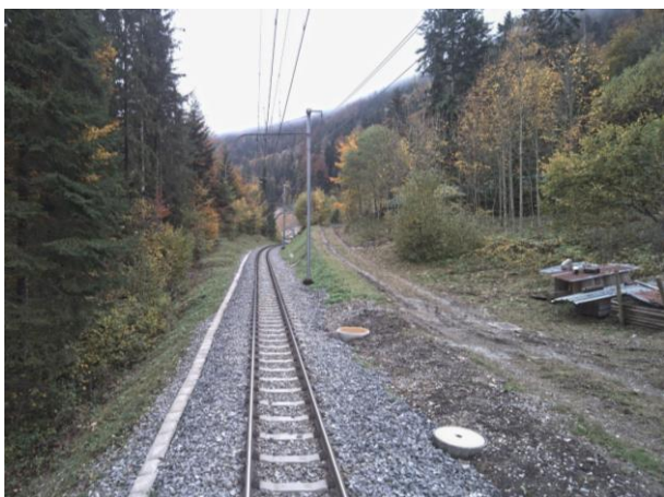
Figure 3 : KM 24.674 – Pleine voie
