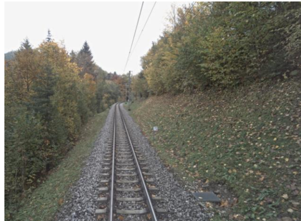
Figure 26 : KM 25.380 – Pleine voie
