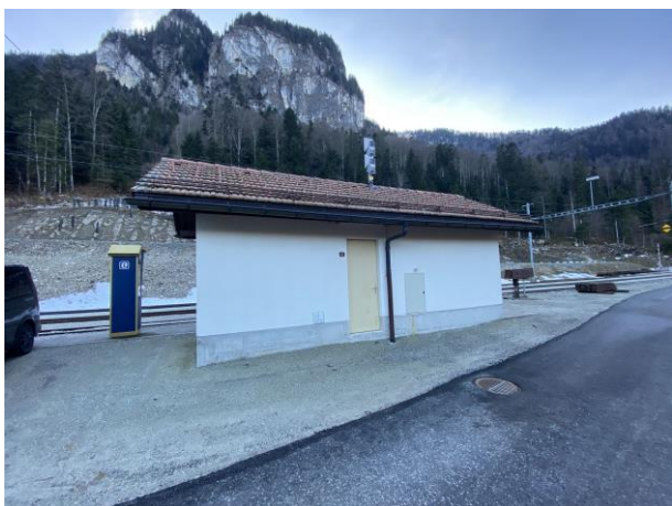
Figure 15 : KM 24.980 – Bâtiment de la gare, façade Nord-Est
