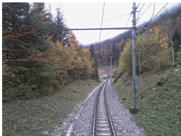
Figure 4 : KM 24.710 – Pleine voie
