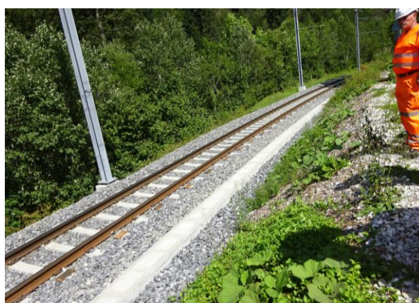
Figure 33 : Zone du Lanciau, pleine voie en aval de la zone du Lanciau
