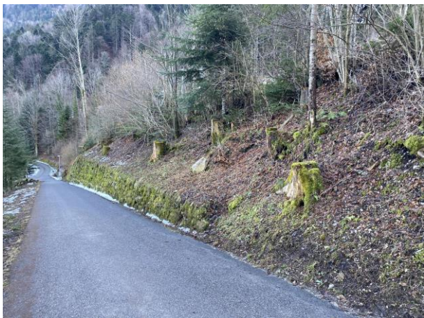
Figure 13 : Route du Revers direction Rossinière, mur existant (accès à la place de la gare)
