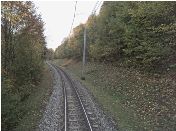
Figure 25 : KM 25.330 – Pleine voie
