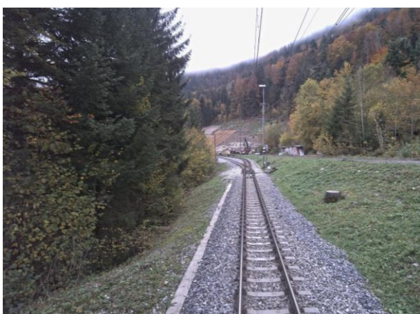
Figure 5 : KM 24.770 – Pleine voie
