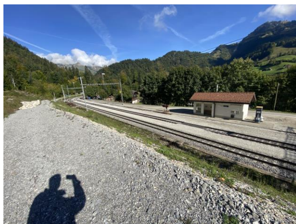
Figure 18 : KM 25.000 – Gare de la Tine, vue amont depuis la route du Revers, direction Montbovon
